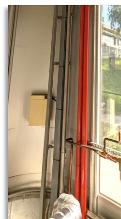
Dépose repose canalisations eau froide pour permettre doublage.
