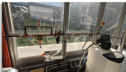
Fixation distribution alimentation eau froide à modifier - Arrêt électrique à déplacer (modification façade)
